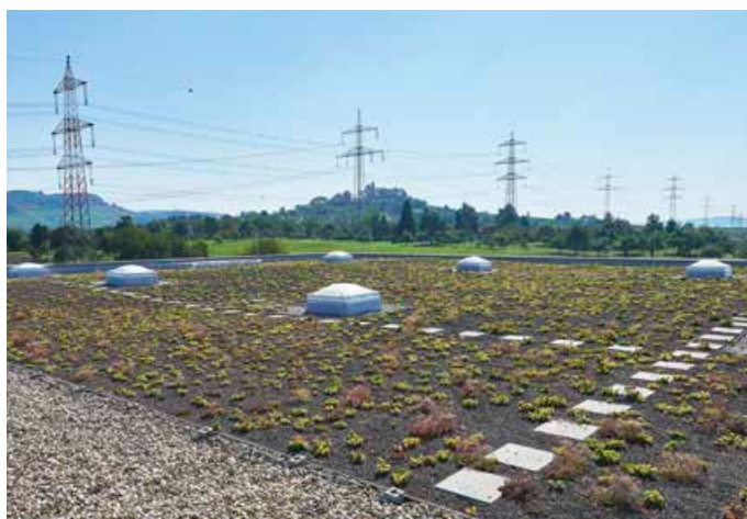
▲ Das Dach des kleineren Kopfbau hingegen wurde extensiv begrünt
