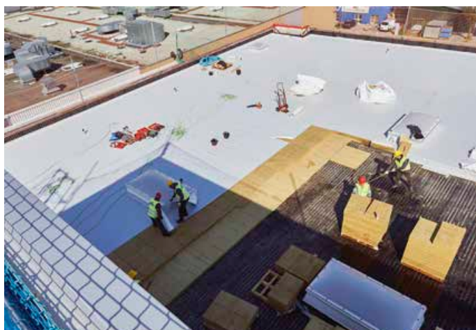
▲ Der gesamte Dachaufbau war durch Versicherer FM Global vorgegeben
