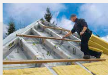
DÄMMUNG Hier geht's lang
