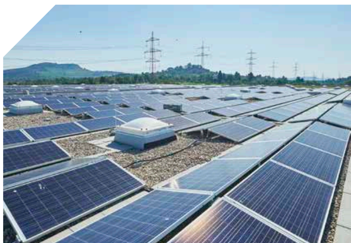
▲ Das Dach der Lagerhalle wurde bekiest und erhielt eine PV-Anlage
