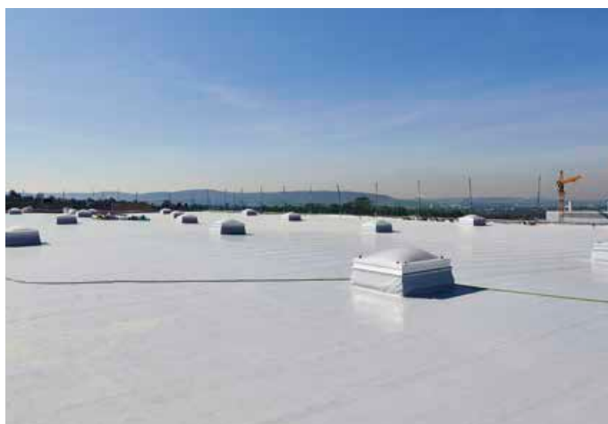
▲ Die Funktion der Abdichtung wurde durch einen Leckagetest geprüft
