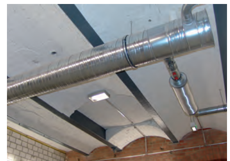
Ob F30 oder F90: Kappendecken erfüllen durch die Brandschutzfarbe Henso-Therm die Vorschriften des Brandschutzes.
