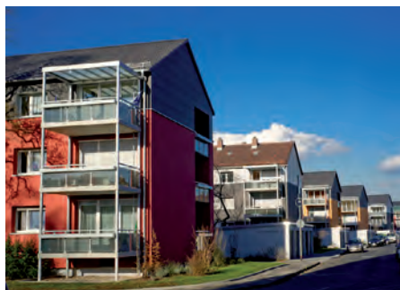
Bei diesen mit VHF-System gedämmten Wohnhäusern in Ludwigshafen kam swissporVENTO zum Einsatz.
