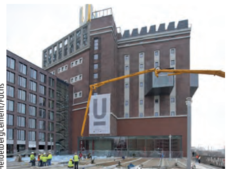
Direkt am „Dortmunder U“ und dem verkehrlich hoch belasteten Wallring sind photokatalytisch aktive Betonoberflächen entstanden.
