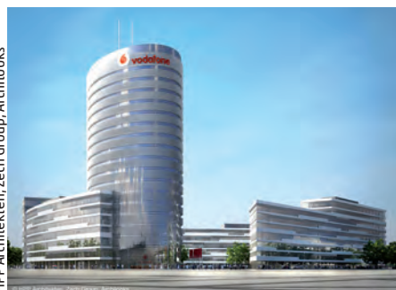
LEED-Vorzertifizierung in Gold dank Cobiasx-Hohlkörperdecken: Der Vodafone Campus in Düsseldorf wurde für sein nachhaltiges Gesamtkonzept ausgezeichnet.
