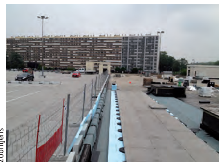
Pardak kann schnell und witterungsunabhängig verlegt werden und ist sofort befahrbar.
