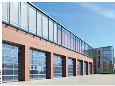
Die bodenflächig verglasten Aluminium-Sectionaltore von Hörmann sorgen für viel Tageslichteinfall und hohe Transparenz.
