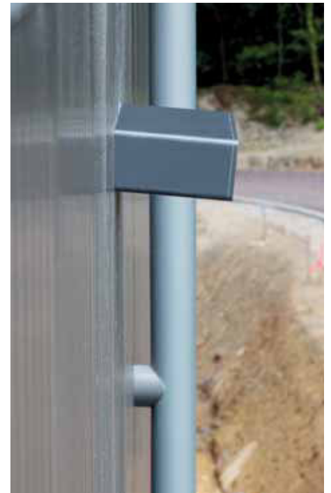
Gerade in Extremsituationen schützen Notüberläufe/Wasserspeier.
