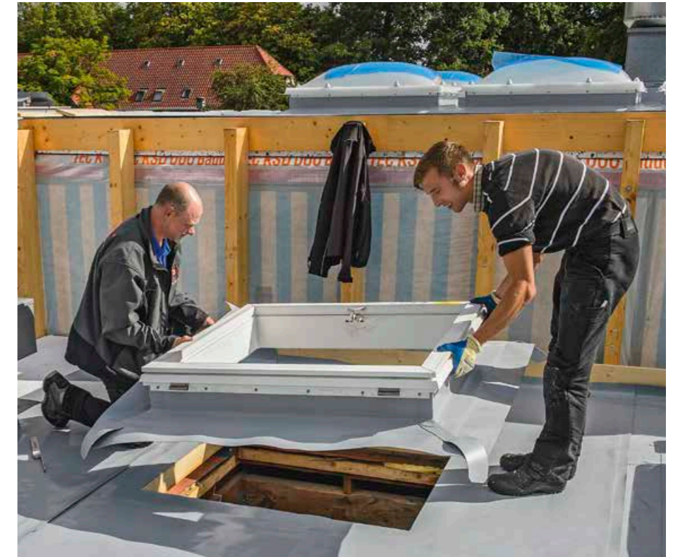
▲ Montage eines Aufsetzkranzes mit vormontierter, materialidentischer Anschlussmanschette
