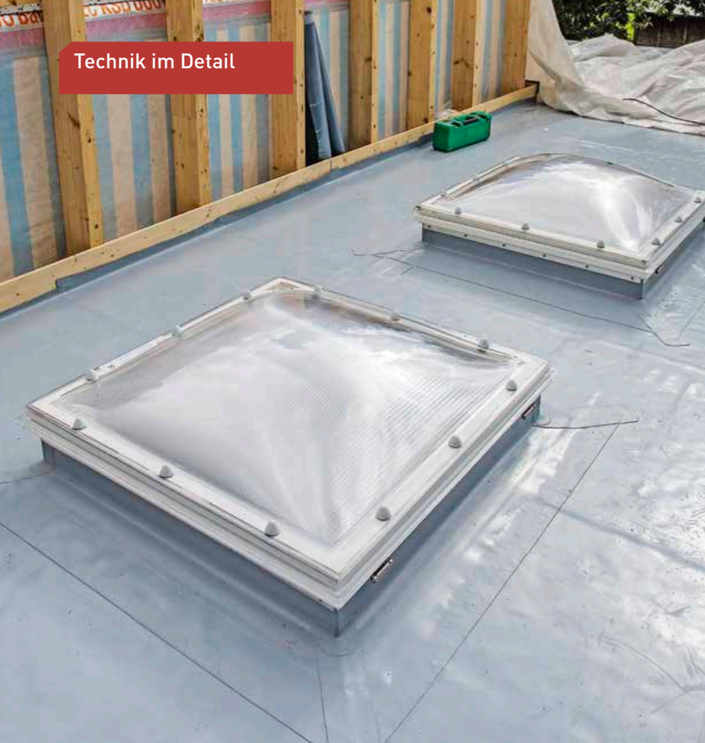
▲ Sicher integriert: Fertig montiertes Dachfenster mit sauberer Anbindung an die Flächenabdichtung
