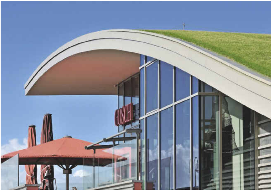
Bei geschwungenen Flachrändern ist vor allem die Außenblende ein markant sichtbarer Teil der Gestaltung.
