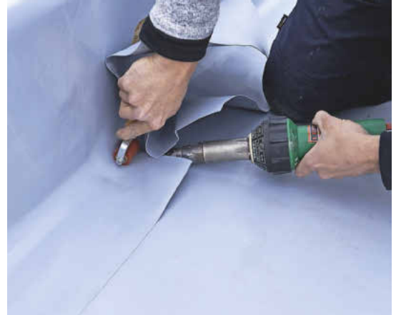
Besonders praxistauglich zeigt sich die eingesetzte Dach- und Dichtungsbahn bei der Detailausbildung und in den Anschlussbereichen.
