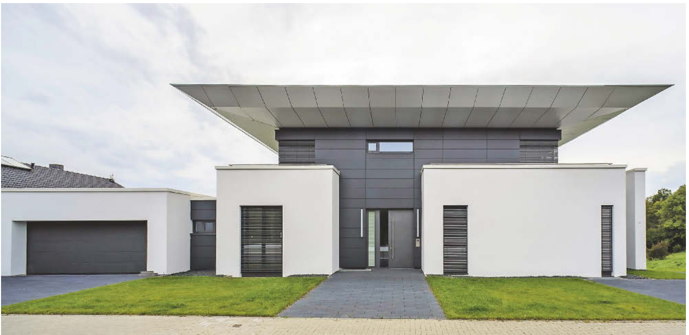
Die auskragenden „Flügel“ verleihen dem Gebäude eine gewisse Leichtigkeit.
