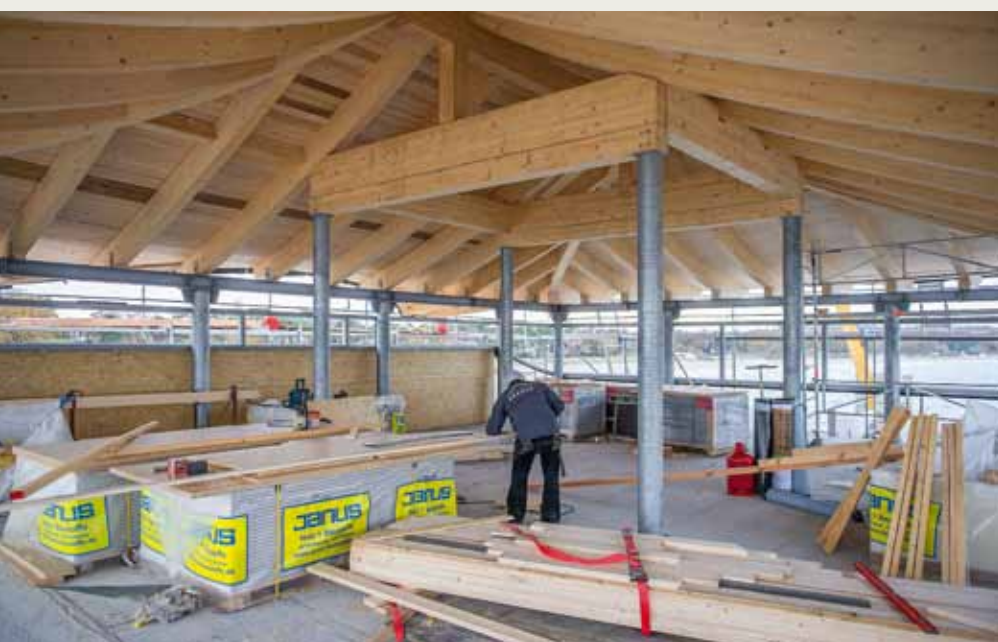
Innenansicht der Pagodendächer mit der Leimbinderkonstruktion
