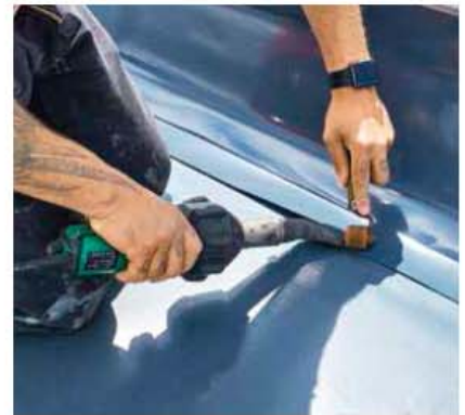
▲ Mit dem Handgerät wird die Manschette dann mit der Flächenbahn heißluftverschweißt
