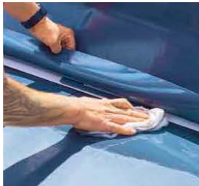
▲ Anschließend müssen Manschette und Dachabdichtung gründlich gereinigt werden
