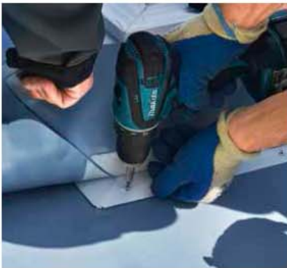
▲ Bevor die Anschlussarbeiten beginnen, wird der Aufsetzkranz im Dachaufbau fixiert
