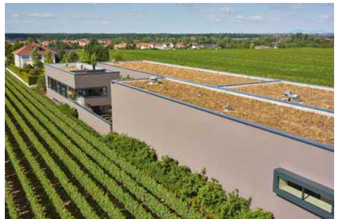
▶ Unter der extensiven Begrünung wurden die langen Flachdächer mit einer EPDM-Bahn dauerhaft abgedichtet
