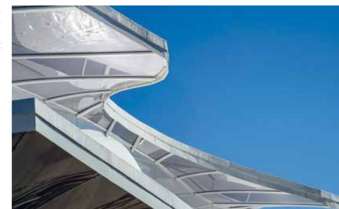
▶ Die zweiteiligen Dachkanten wurden mit Verbundblechen ausgebildet
