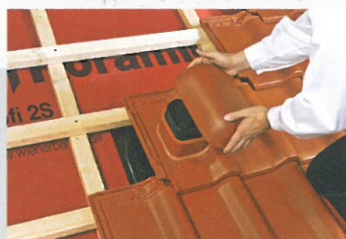
STEILDACH Dunstrohr im Detail
