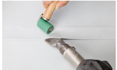
Mit einer parallel zur Düsenöffnung geführten Silikon-Andruckrolle werden die plastifizierten Überlappungsbereiche durch mäßigen Druck gefügt. Durch das Schweißen im Rückwärtsgang bläst die Düse immer gegen bereits dichtgeschweißte Nahtbereiche.
