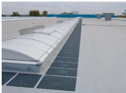
charges. Le soudage à l'air chaud avec les membranes d'étanchéité EVALASTIC® leur assure un positionnement fiable, même en cas de fortes charges dues au vent. La séparation optique entre membrane d'étanchéité et dalle de protection présente un autre avantage: elle délimite les chemins de circulation pour un déplacement sécurisé des personnes sur les toitures terrasses.
